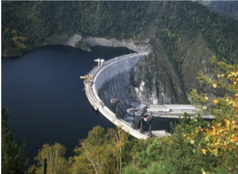
Рис.5. Вид плотины СШ ГЭС.
